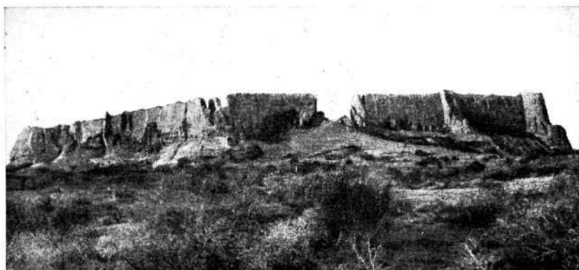
Рис. 5. Общий вид Беркут-кала с юго-востока.
