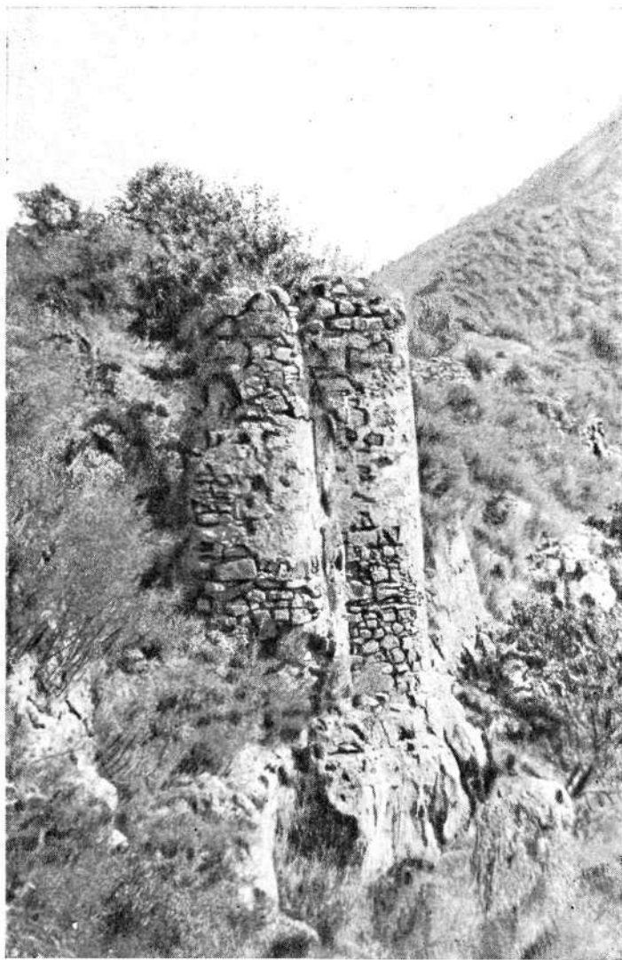
Рис. 3. Контрфорс городской стены.
