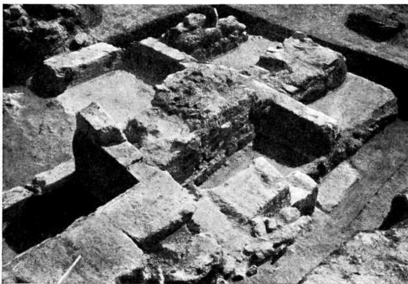
Рис. 4. Фундаменты стен базилики внутри рыбозасолочных ванн. Вид с запада.
