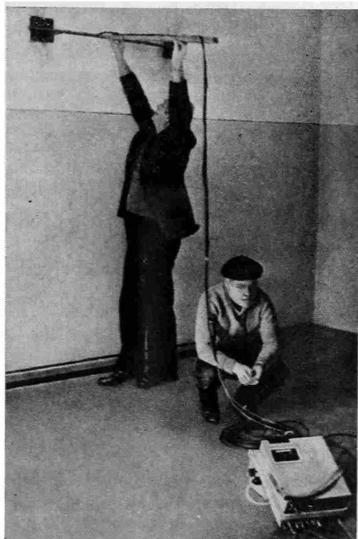
Рис. 6. Зондирование стен помещения в Вентспилском замке
