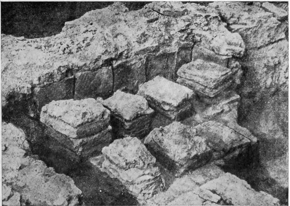
Рис. 7. Вид отопительной системы в южной половине банной постройки в Киеве (по М. К. Каргеру)
