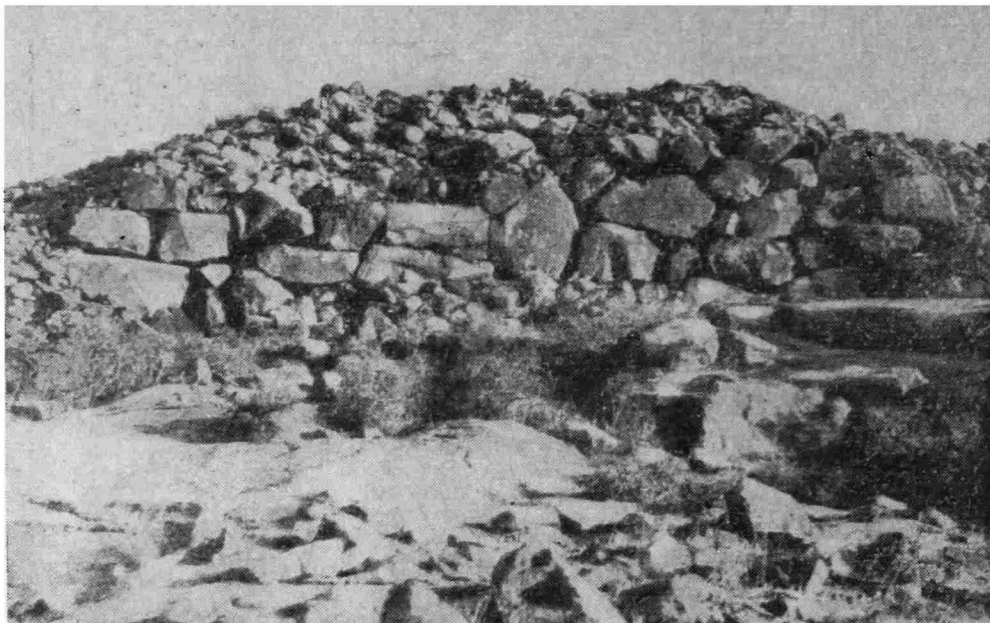
Рис. 2. Нижняя циклопическая кладка крепостной стены
