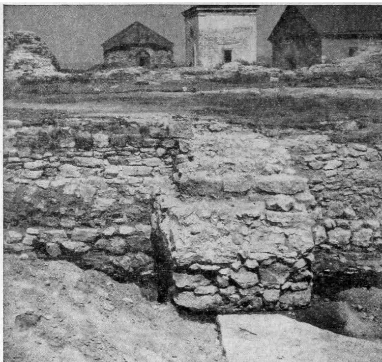
Рис. 7. Кладка южной стены
