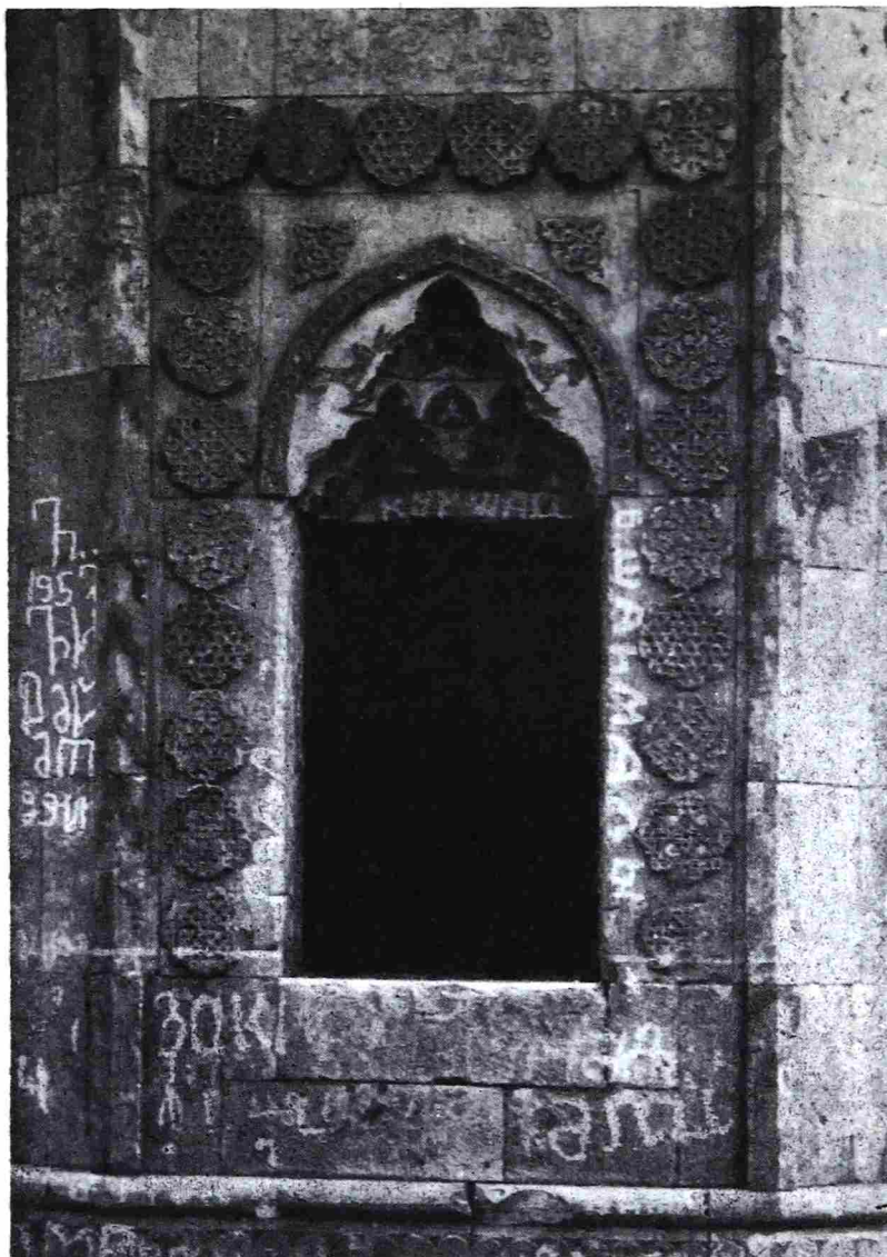
Рис. 3. Вход в верхнюю камеру (грань № 1)
