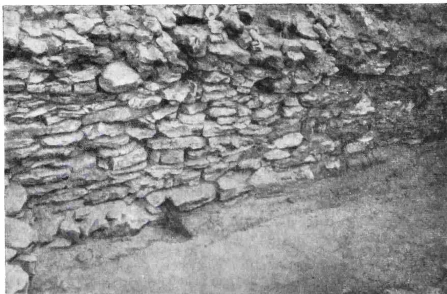
Рис. 5. Внешний вид северной стены дромоса с внутренней стороны (хорошо заметны продольные и поперечные пустоты от бревен)
