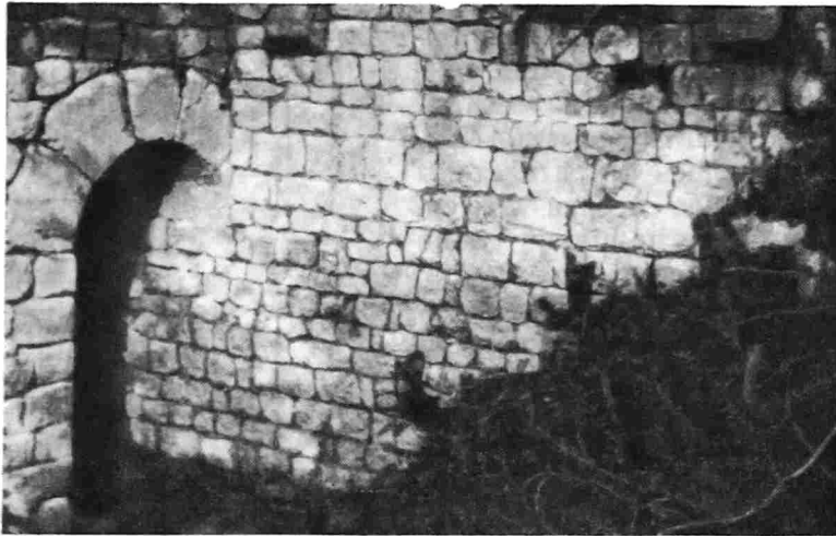
Рис. 3. Внутренний вид нижнего помещения башни «А»
