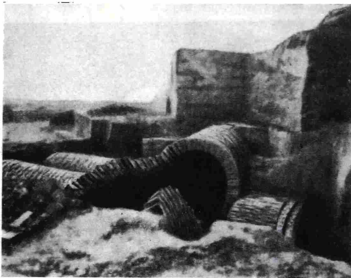
Рис. 7. Крестовый свод над многокомнатным кирпичным склепом (из раскопок у г. Хэфей)
