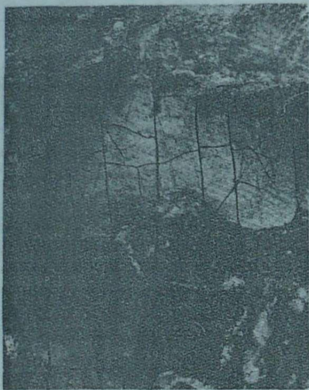
Рис. 8. Кракелюр грунта и красочного слоя.
