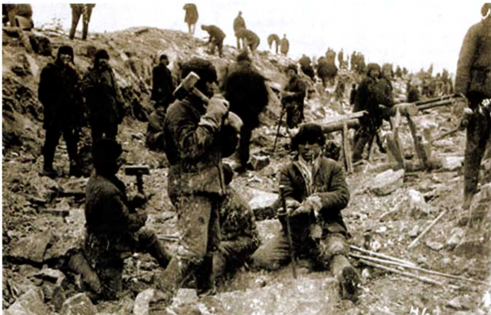
Объект ОГПУ – Туломская ГЭС.
