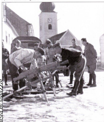
Немецкие солдаты чистят станковые пулеметы Schwarzloze, восточный фронт. Австрийские пулеметы были рассчитаны или под 7,92x57 патронов или под 8-мм патрон обр. 1893 г. Питание — 250-зарядная матерчатая лента. Скорострельность порядка 500 выстрелов в минуту.
