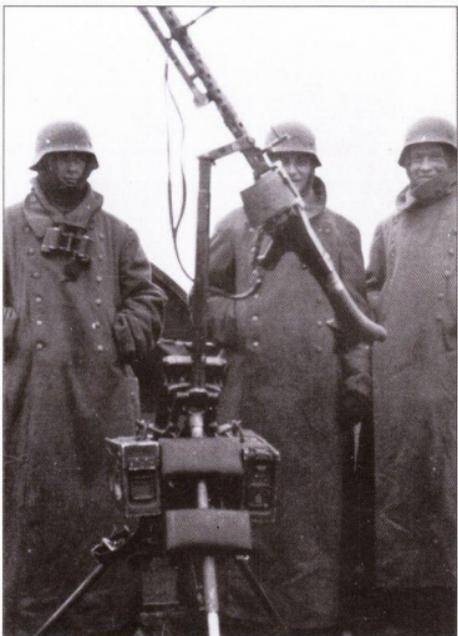
Пулемет MG 34 на трехном станке, разложенном для стрельбы по воздушным целям. Пулемет оснащен 50-зарядным барабанным магазином Gurttrommel.
