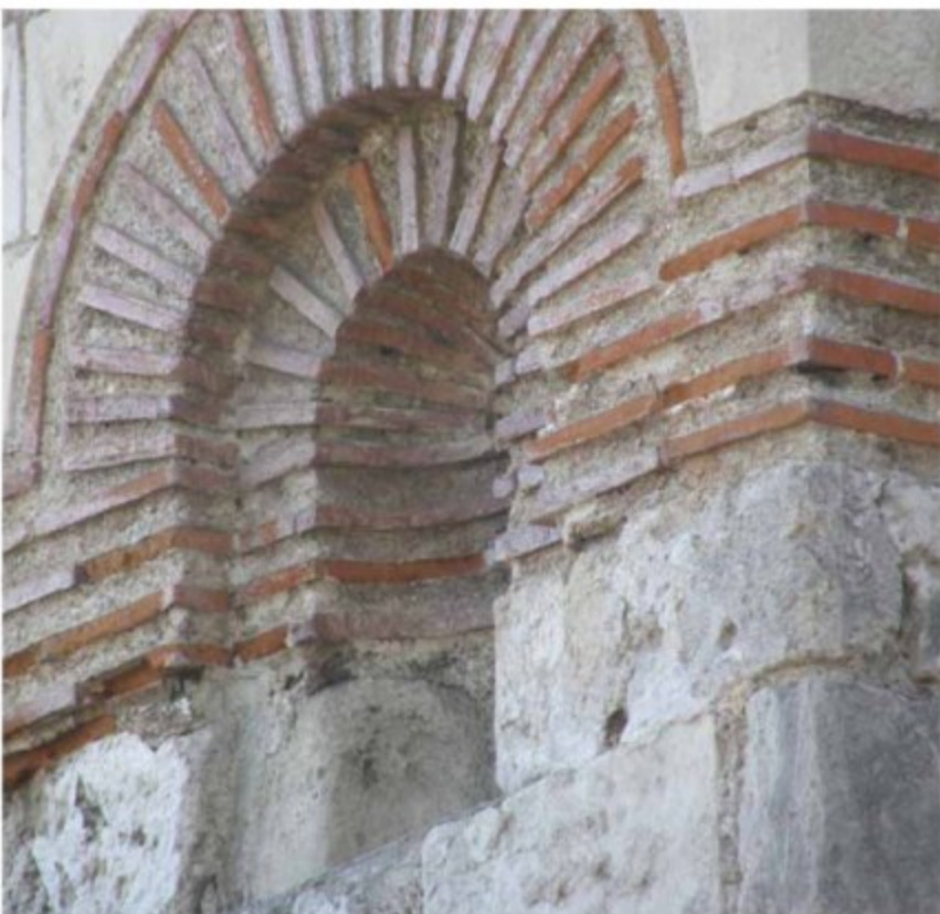
Кладка из плинфы
